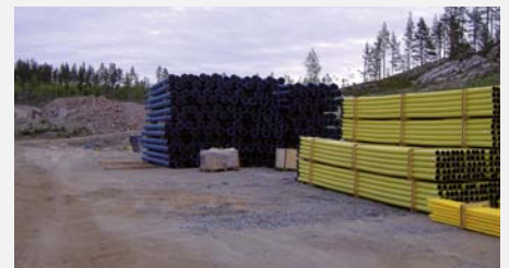
In Reih und Glied zwischengelagert
